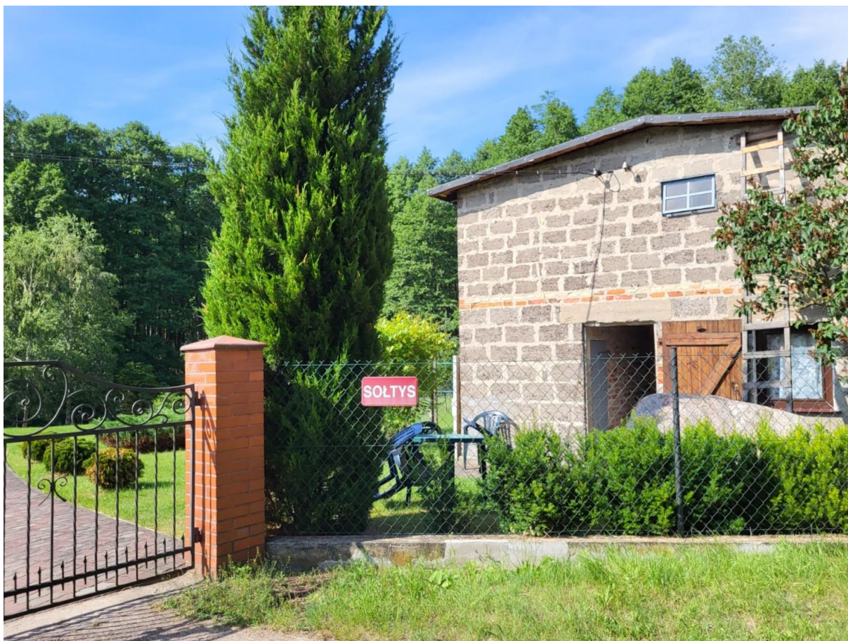
Fot. 2. Zabudowa mieszkaniowa w granicach działki nr 36/26 obręb Cierpice
