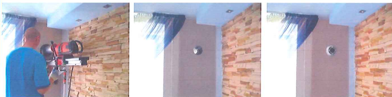
Rys 4. Wzór montowania układu wentylacji dolotowo-wyciągowej PRANA-150, PRANA-200.
