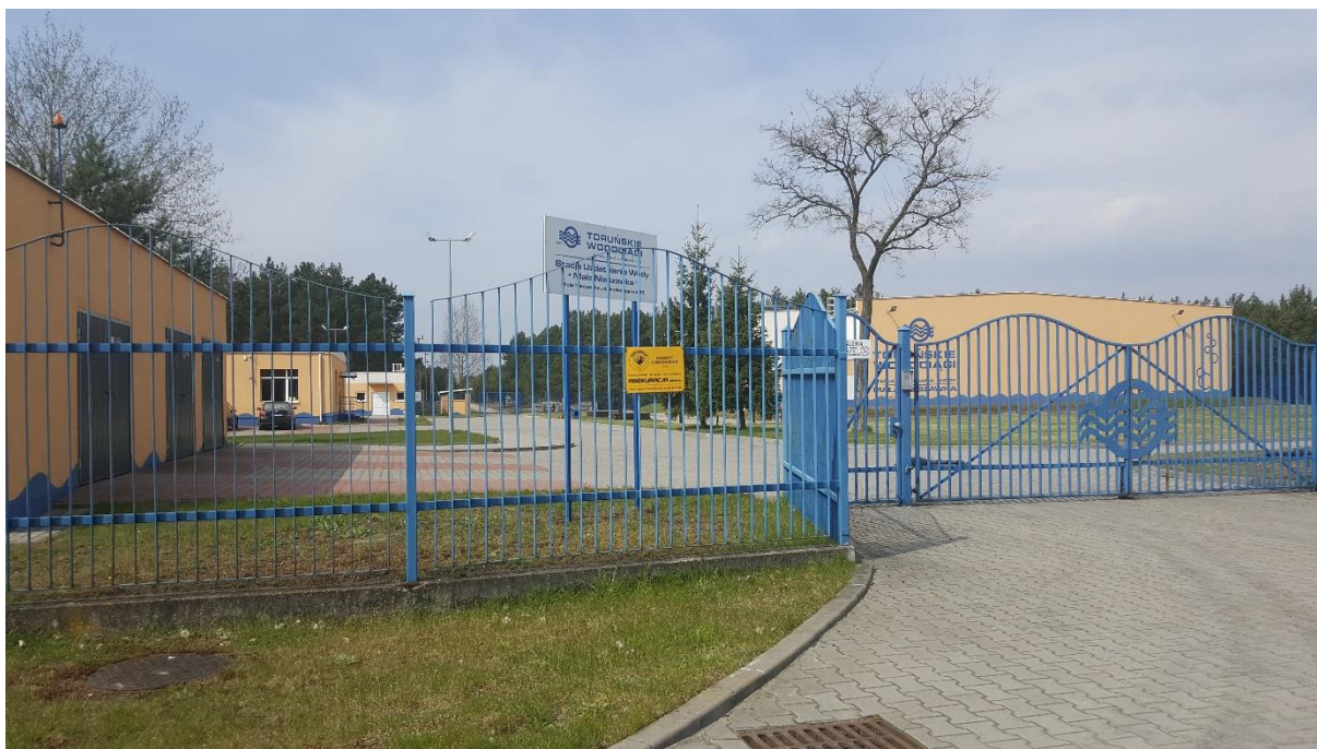
Fot. 7. Budynki Stacji uzdatniania wody „Mała Nieszawka” przy ul. Wodociągowej 28
