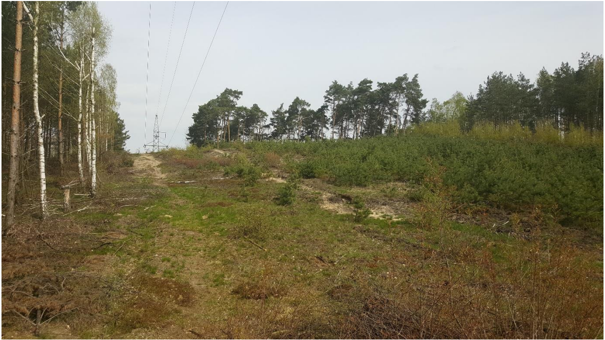
Fot. 3. Teren pozbawiony roślinności wysokiej w pasie technicznym napowietrznej linii elektroenergetycznej wysokiego napięcia
