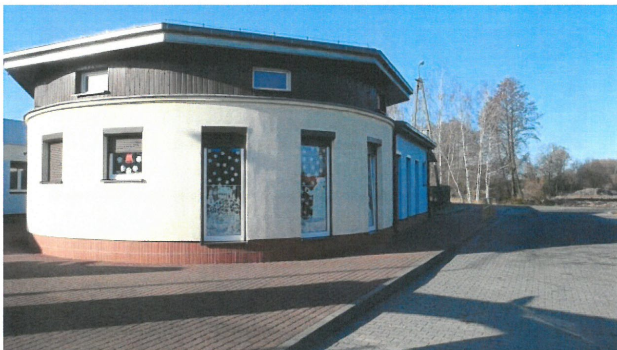
Zdjęcie 2. Budynek zlokalizowany przy ulicy Leśnej 1 w Małej Nieszawce
